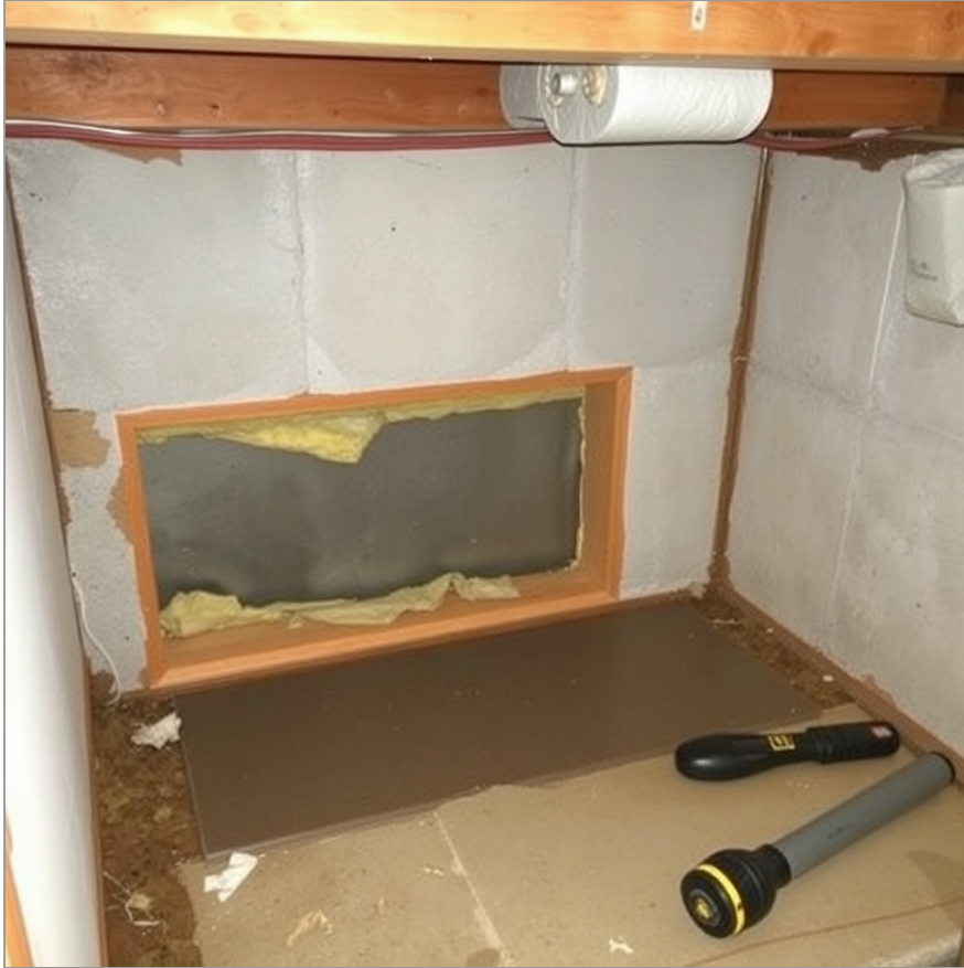
Öffnung am Estrichrand zur Feuchteprüfung
