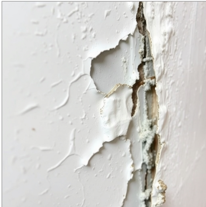
Feuchtebedingte Anstrichblasen an der Zimmerdecke darunter
