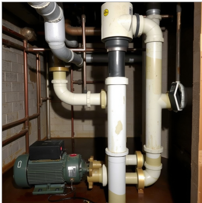
Leitungsbereich über der Deckenbekleidung nach Freilegung
