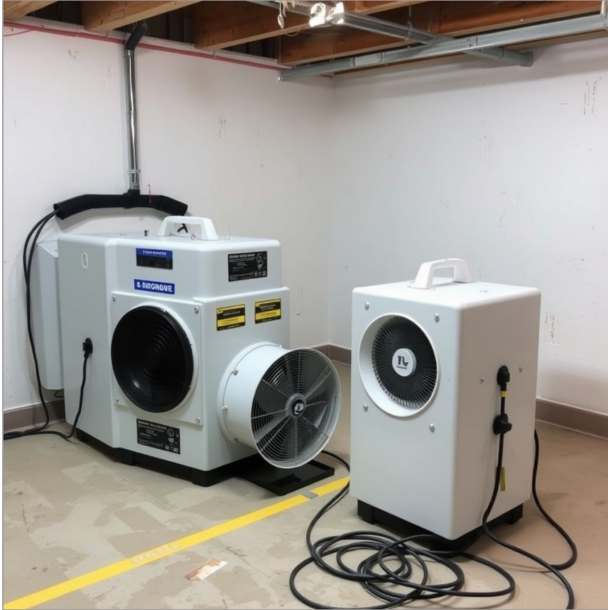
Bautrocknung/Entfeuchtung während der Maßnahme
